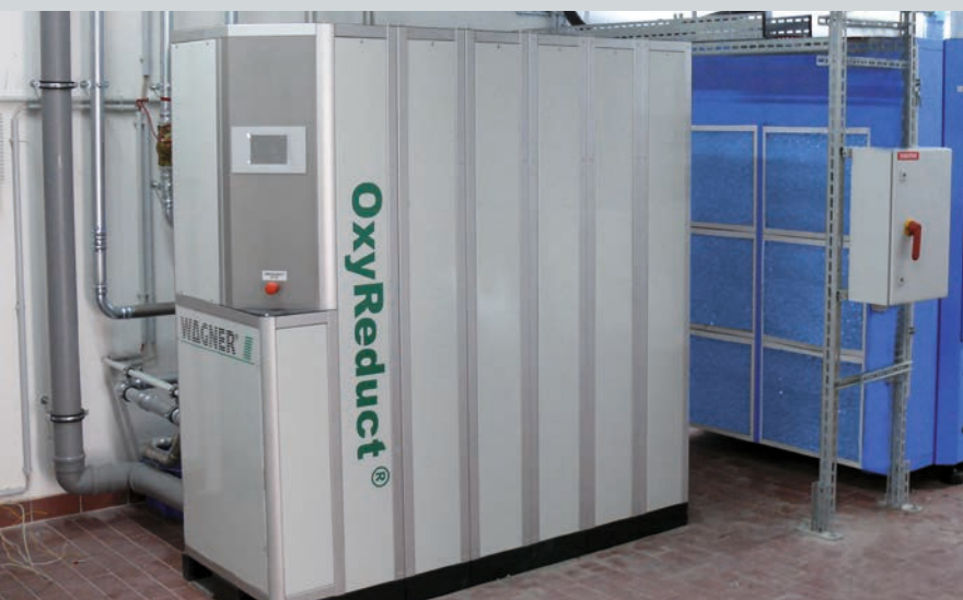
Stikstofgenerator (links) voor de productie van stikstof, een van de hoofdcomponenten van een OxyReduct®-brandpreventie-installatie.
