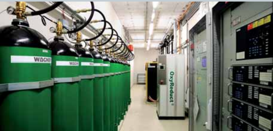
Système de prévention des incendies OxyReduct® avec réduction rapide du taux d'oxygène.
