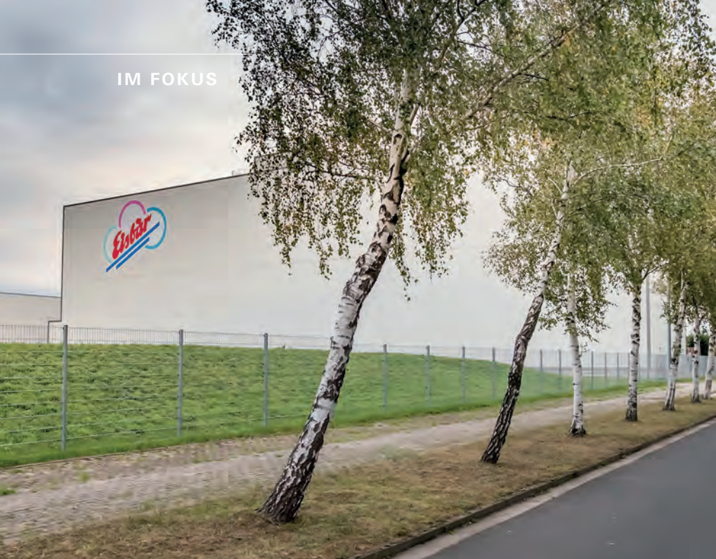
▲ Eisbär Eis: Ein OxyReduct®-System mit VPSA-Technologie schützt den Tiefkühlkomplex.
