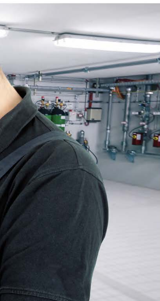
◀ Die Wiederbefüllung von Stickstoffbehältern bietet sich insbesondere dann an, wenn sich die Löschanlage in einem schwer zugänglichen Bereich befindet.
