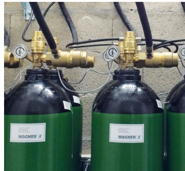
▼ Softflutung: Die Löschflaschen sind mit Durchflussreglern ausgestattet.
