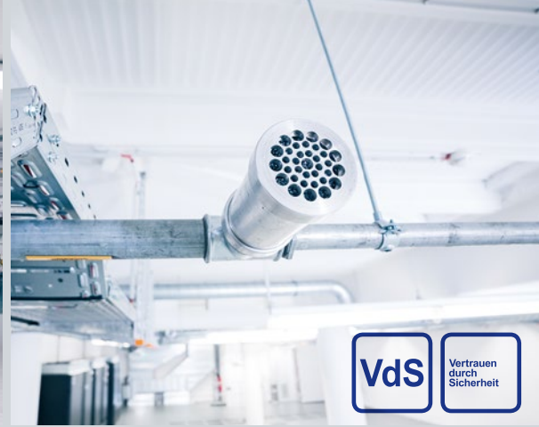
▲ Löschdüsen mit speziellen Schalldämpfern.
