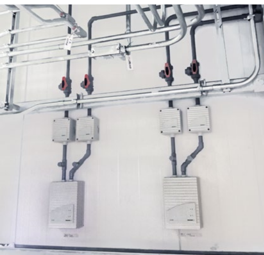
▲ Die OXY-SENS® Sauerstoffsensoren werden mit dem Ansaug-Rohrnetz verbunden
