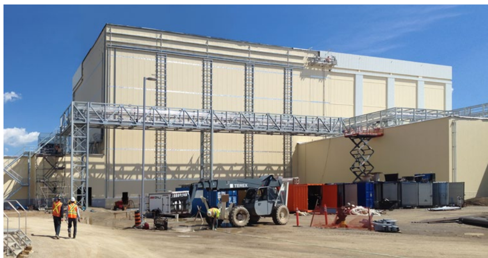
▲ Oktober 2014: Das Tiefkühlhochregallager von Dr. Oetker während der Bauphase. Der Betriebsraum der OxyReduct®-Anlage ist schon fertiggestellt
